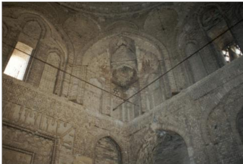
تصویر ۸) منطقه انتقالی گنبدخانه مسجد برسیان (مأخذ: آرشیو میراث فرهنگی اصفهان)
